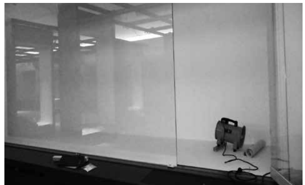
3-f ケースの改修工事 内装壁を復元した状況と換気
