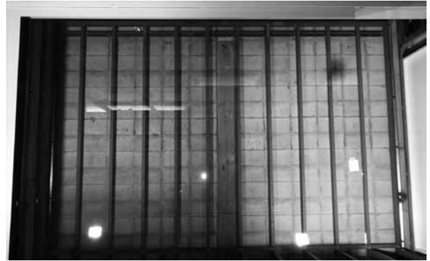
展示ケース（3-f）の改修工事 内装壁を撤去した状況
